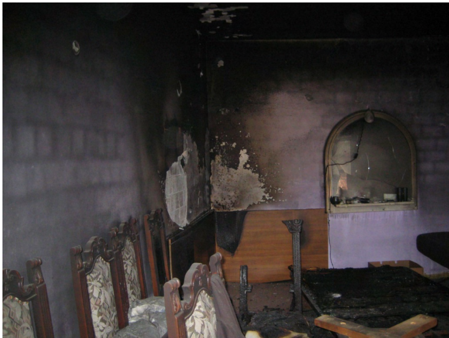
Foto 22 e 23: camera 1 piano secondo
